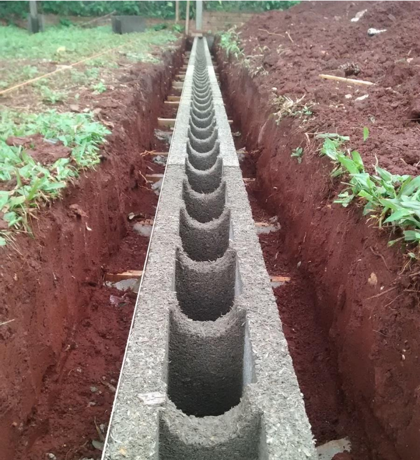
Muro lindero, Subestación EMSA, Iguazú, Misiones
